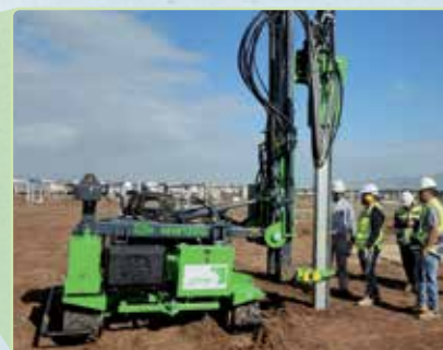
מכונת נעיצה, של חברת מעגלים אנרגיה, מהמתקדמות בעולם (ללא שימוש בבטון)
